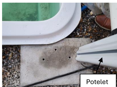
Exemple de perçages sur plot pour une piscine coque.
