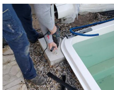
Exemple de perçages sur plot pour une piscine coque.
