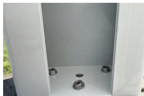
Serrer les vis de fixation.
