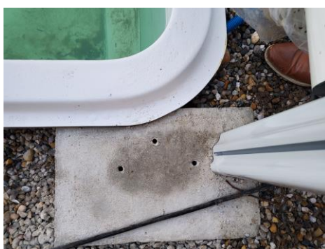
Exemple de perçages sur plots pour une piscine coque.
