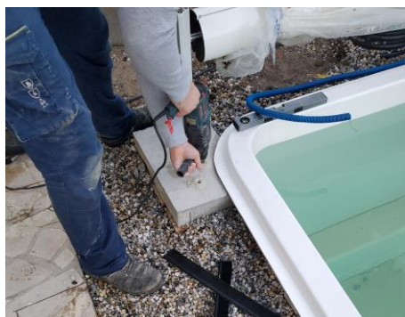
Exemple de perçages sur plots pour une piscine coque.
